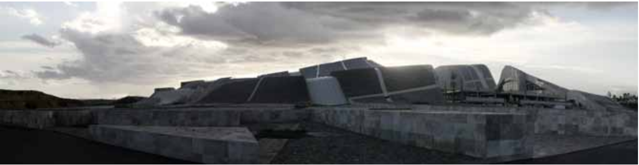
Vista exterior de la "Cidade da Cultura", Monte Gaiás, Santiago de Compostela (2011)
