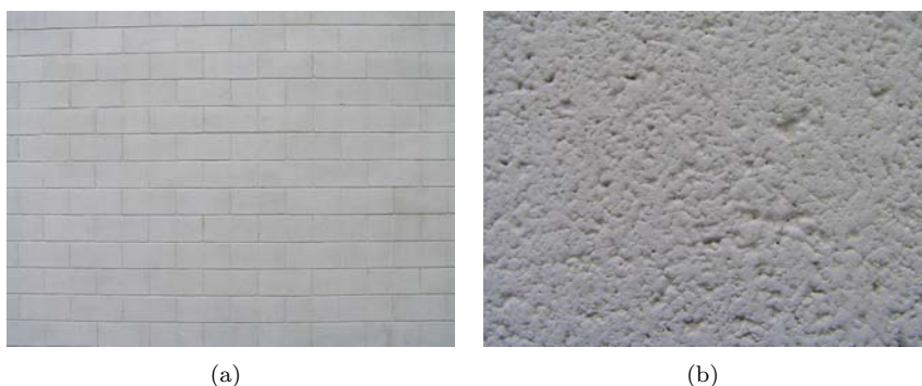
Figura 1.2: Influencia de la escala sobre la textura: macrotextura (a) y microtextura (b) de una pared de bloques de hormigón.
